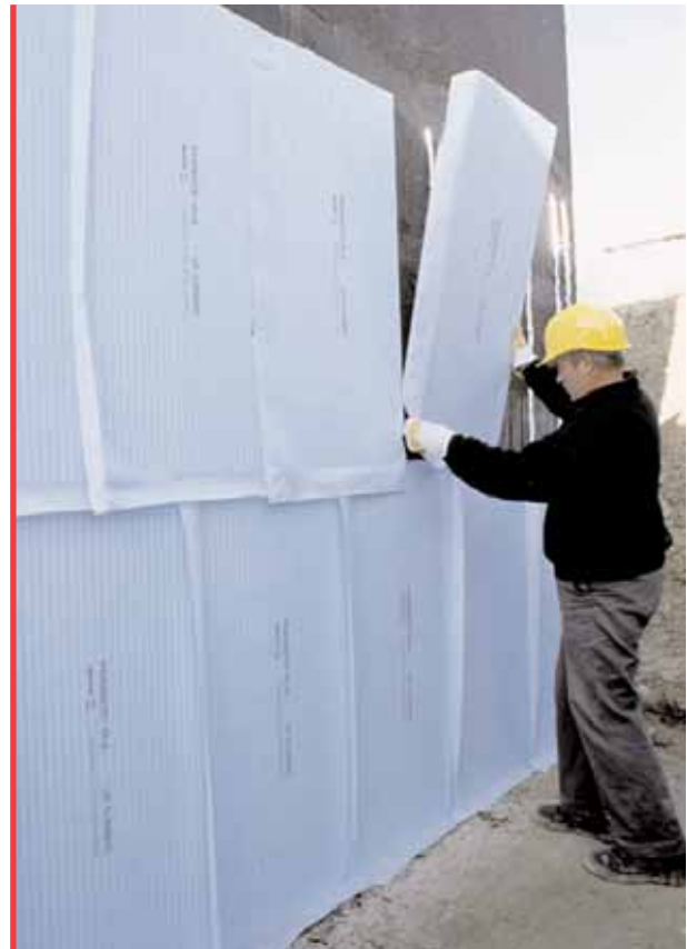
Verlegung der PERIMATE™ DI-A Dämm-/Dränelemente
