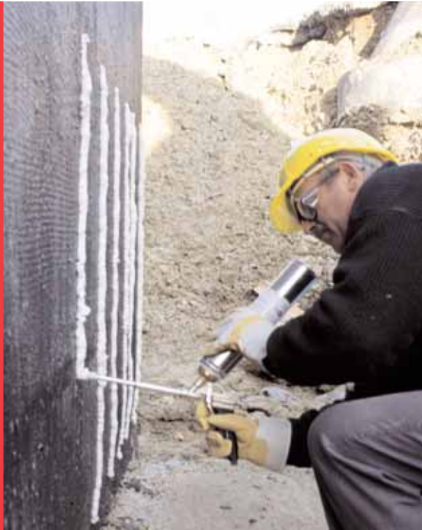
Aufbringen des Klebers auf die Kellerwand
