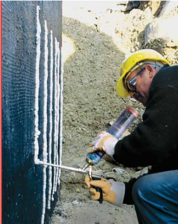
Aufbringen des Klebers auf die Kellerwand
