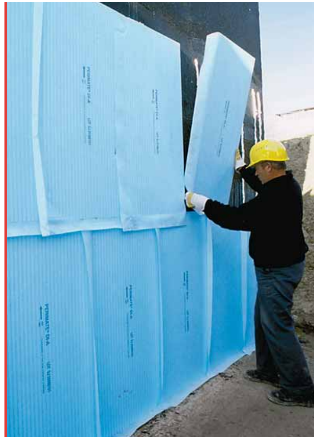
Verlegung der PERIMATE™ DI-A Dämm-/Dränelemente
